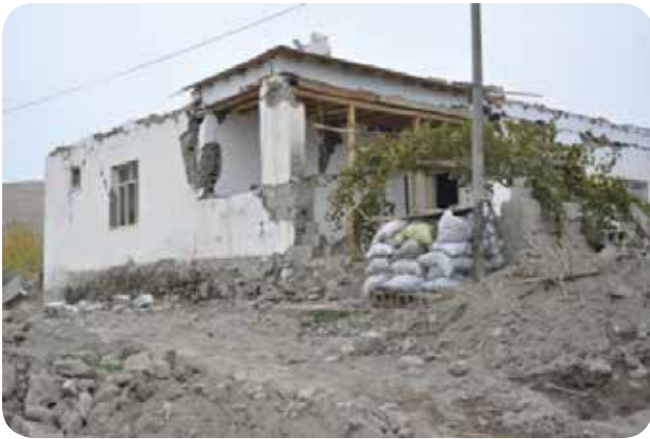
شکل ۳- ساختمان‌های با کیفیت پایین و ارتفاع کم که دچار تخریب وسیع نشده‌اند
