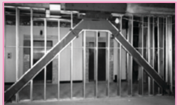
شکل ۱- نمونه ای از بکارگیری میراگر اصطکاکی بر روی بادبند چورن
