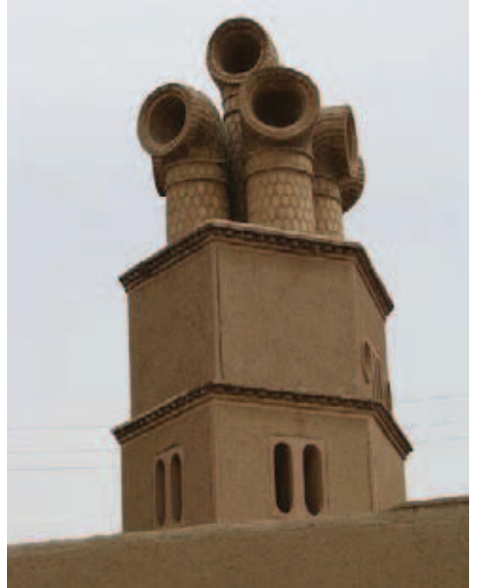
شکل ۴: نمایی از یک بادگیر چپقی در سیرجان
